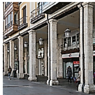
Figura 4. Columnas en la calle
