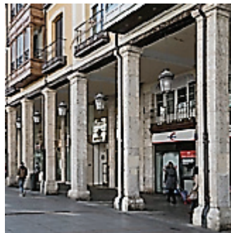
Figura 4. Columnas en la calle
